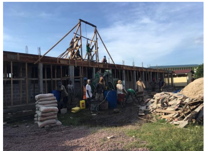
14. November: Die Stahlbeton-Decke: Eine fröhliche Truppe bei einer anstrengenden Choreographie.
