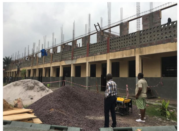
Bau des oberen Stockwerks mit 6 neuen Klassenräumen im Jahr 2022
